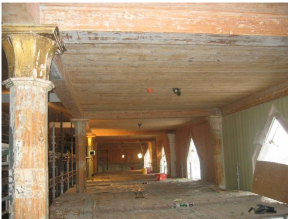
Seinät, katot ja penkit puhdistettiin puupuhtaiksi
